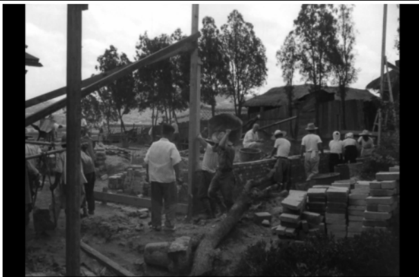
화도예배당 건설공사 장면
