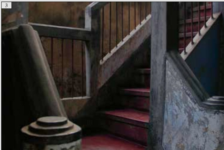
계단, 콜카타 북부 2012. Stairwell, North Kolkata 2012.
